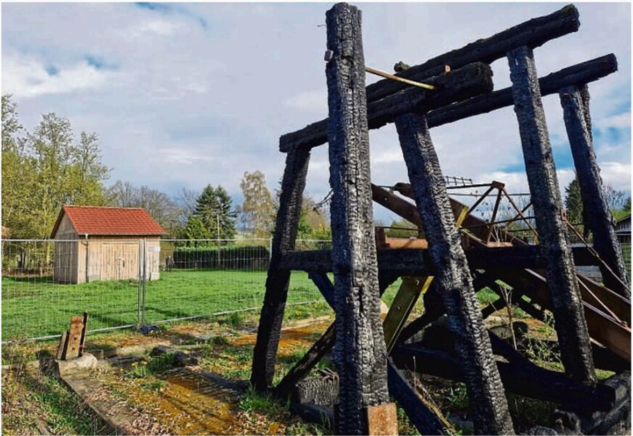
Nur noch ein paar verkohlte Balken vom Gerüst sind von der Saline erhalten. Im Hintergrund sieht die vom Kultur-Förderkreis erstellte Bauhütte, die für die Sanierung der Fördertechnik gebraucht wird.
